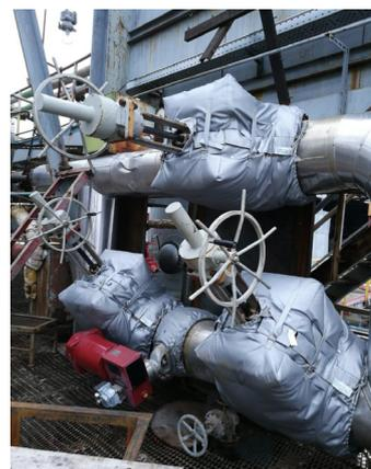
Стеклоткань с силиконовым покрытием имеет широкий диапазон рабочей температуры от – 50°C до + 250°C.
